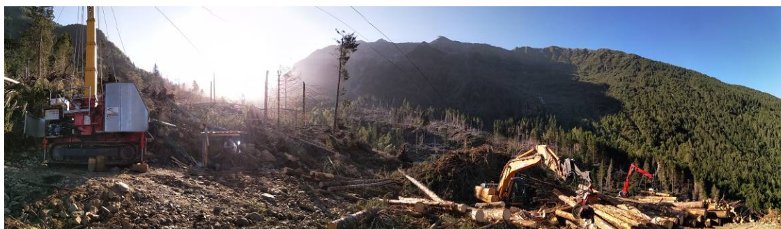
Fig. 31 - SONICO: cantiere forestale in Val Malga (2019)
