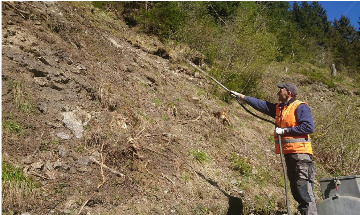
Fig. 20 - SAVIORE DELL'ADAMELLO: idrosemina per contenere l'erosione superficiale a Fabrezza (2019)
