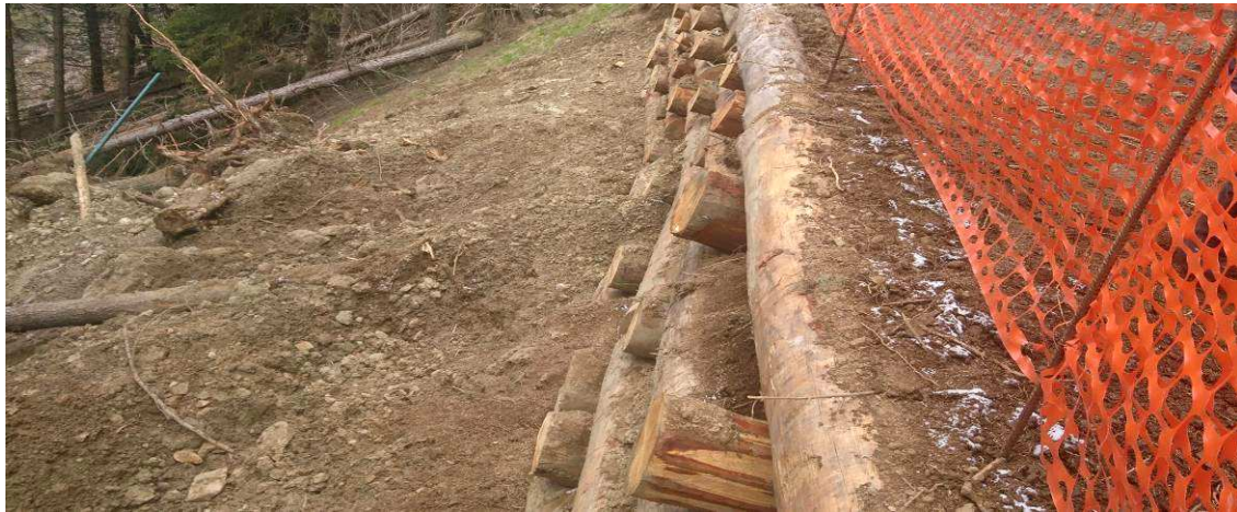
Fig. 39 - PONTE DI LEGNO: palificata doppia al Recinto faunistico (2018)
